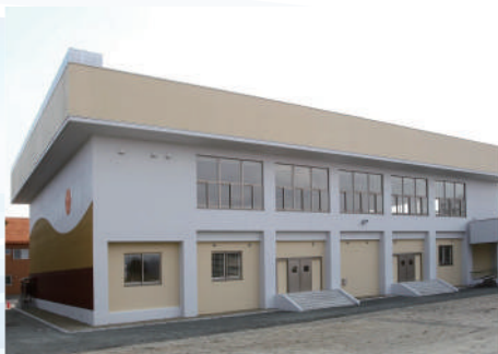
青森市立西田沢小学校校屋内運動場改築工事
