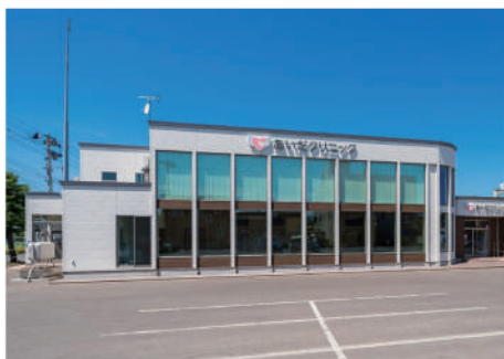
あいだクリニック新築工事
