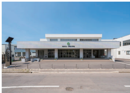
青森市立小柳小学校校舎等改築工事
