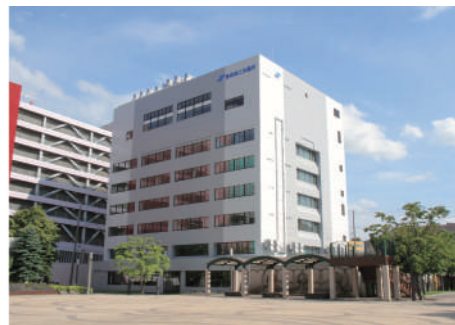
青森商工会議所会館改築工事
