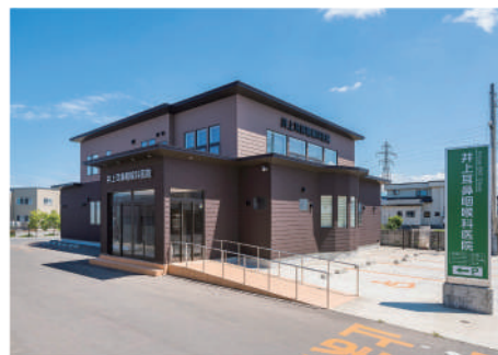
井上耳鼻咽喉科医院新築工事
